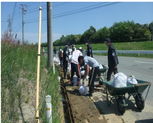
5.24 新地町泥出し
