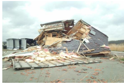
倒壊した住宅
