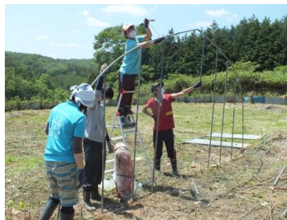
6/9 ビニールハウス解体
